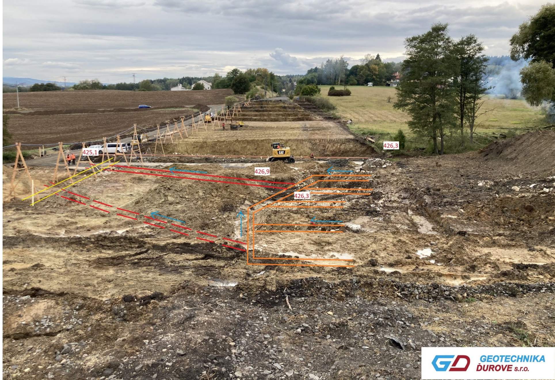
Pohled na soustavu historických odvodňovacích prvků na kontaktu násep/podloží
